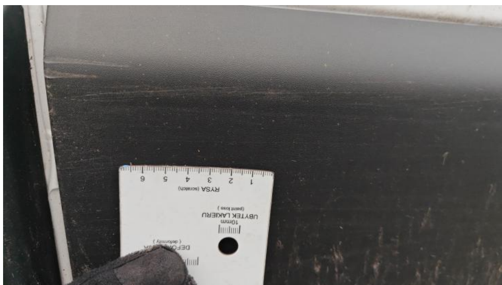
Fot. 45. Listwa błotnika n/lakier. TP - zarysowanie 1
