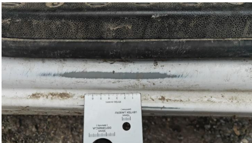
Fot. 86. Próg L - zarysowanie 1
